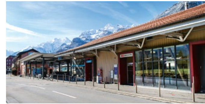
→ Trotz Baustelle werden am Bahnhof Altdorf der öV sowie die Dienstleistungen aufrecht erhalten.
