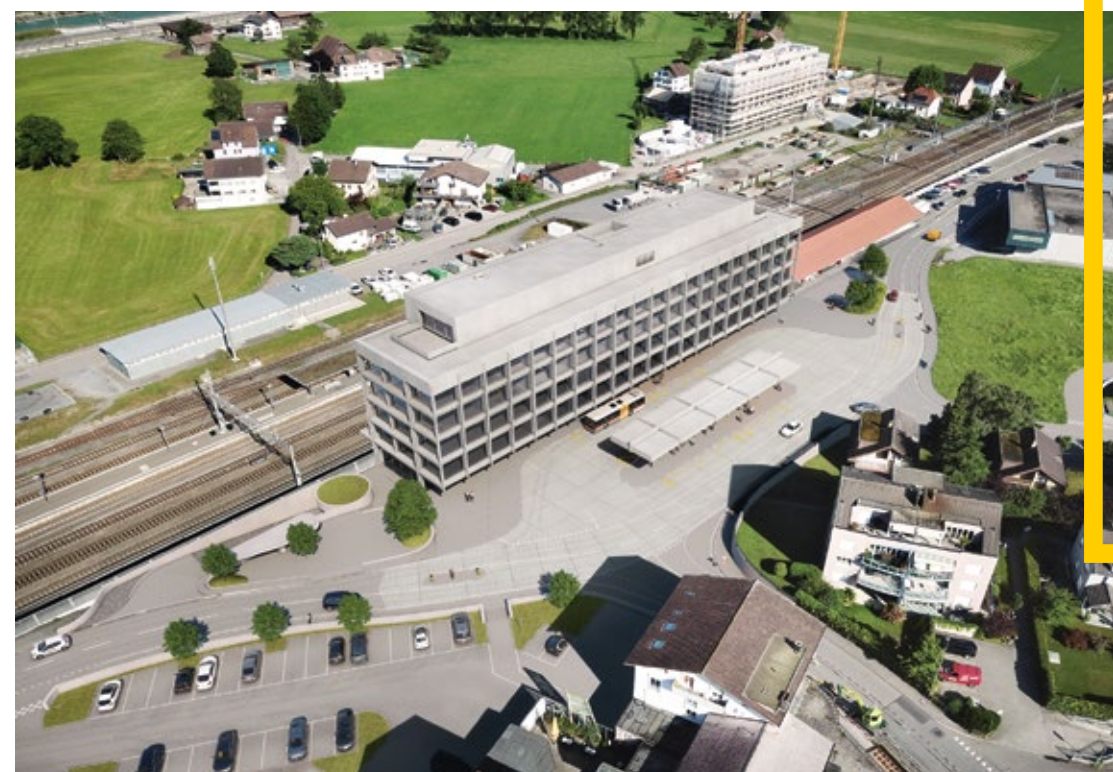
→ Blick von oben: Der Kantonsbahnhof in Altdorf mit dem neuen UKB-Gebäude und dem davor liegenden Bushof.
